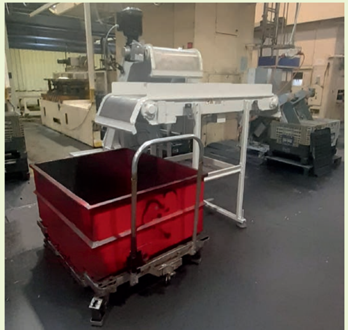
Die vorhandenen Bänder sammeln den gesamten Schrott von den vier Pressen.
